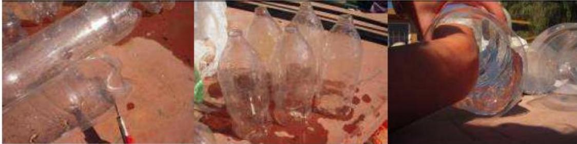
f) A continuación, las botellas de menor diámetro (de 1,5 lt) con el papel reflejante se introducen dentro de las botellas de mayor diámetro y insertando en el caño de polipropileno de 1/2". Ver Fig. 4.
